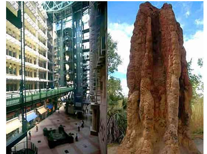
De East Gate toren in Zimbabwe is ontworpen op basis van een termietenheuvel. Dit gebouw gebruikt 10% van de energie die normaal zou zijn voor zo'n gebouw.
