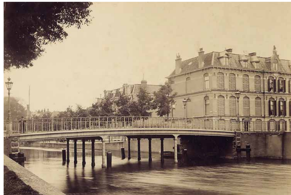
Nassaubrug met bebouwing Nassauplein, 1890, NHA.
